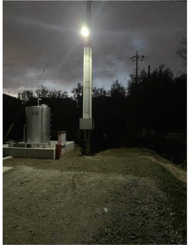
高さ約 6m への設置例と点灯の様子です。ステンレスバンドで電柱への取付けも可能です。
